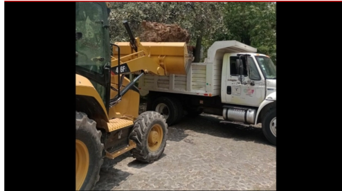
Hace un año la alcaldía Coyoacán dio como "atendido" un reporte vecinal para que dictaminara el riesgo de dos árboles sobre el andador Retorno 1 de Omega, casi esquina con Épsilon, en la colonia Romero de Terreros, por estar inclinados. En la imagen, tala en dicha zona, realizada el 17 de mayo de 2023. Foto tomada de Twitter @Alcaldia_Coy
