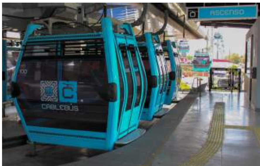
Línea 1 y 2 de Cablebús
