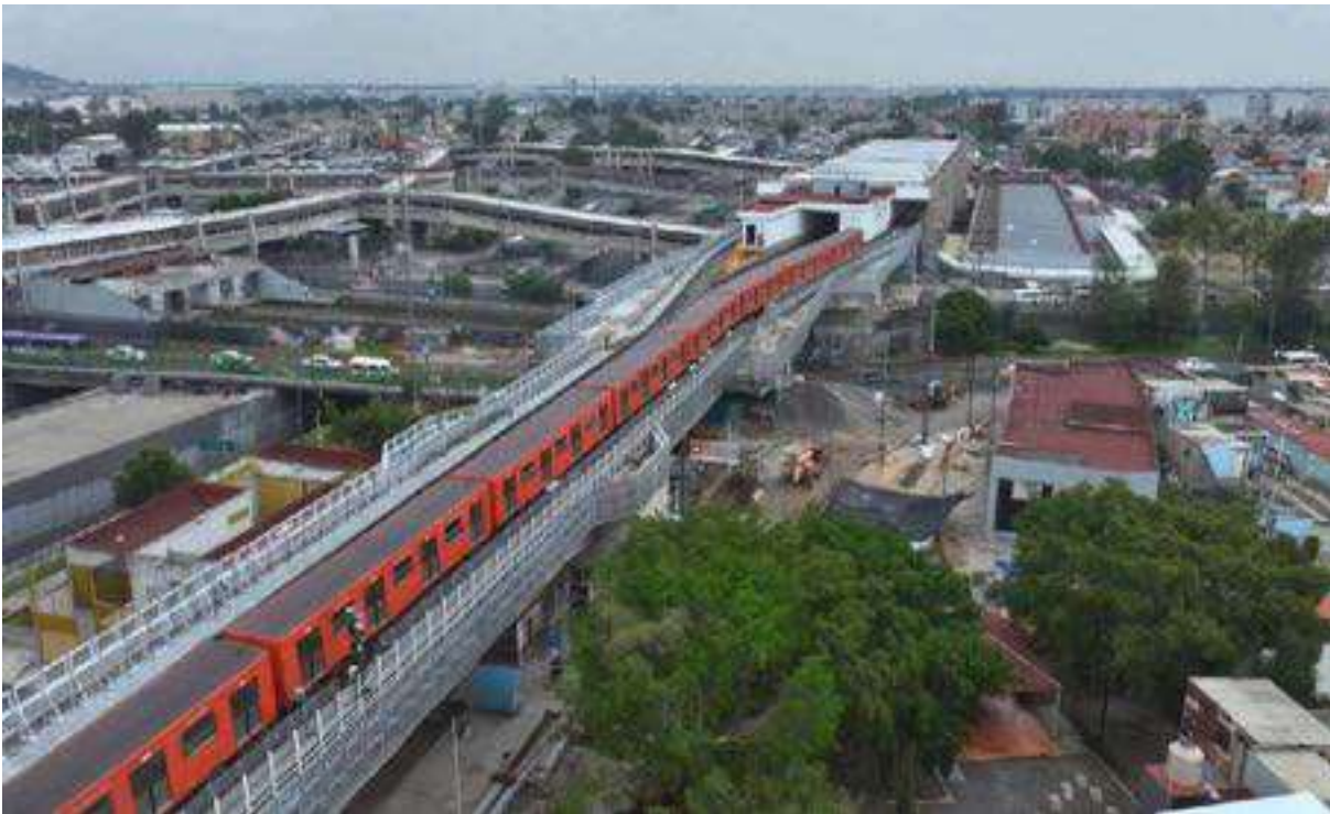
Renivelación de la L9 de Metro, tramo Pantitlán - Ciudad Deportiva.
