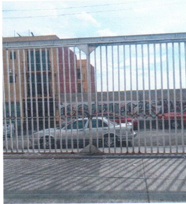
Reparación de Reja
