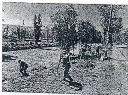
Fotografía 3. Limpieza de Canal, paraje San Miguel (antes).
