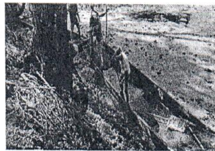
Fotografía 6. Limpieza de canal y chaponeo, paraje San Bartolo.
